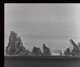
Descascamento GSC (Concentração de tensão geométrica)
