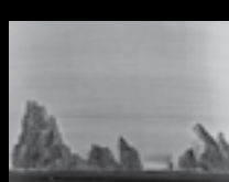
Descascamento GSC (Concentração de tensão geométrica)
