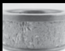
Descascamento grave por cargas pesadas
