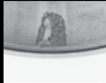
Resultando em descascamento localizado na pista
