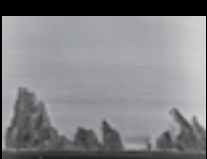
Ecaillage dû à la concentration de contraintes géométriques (GSC)
