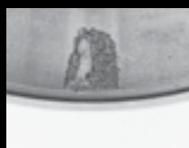
Rezultă exfoliere localizată pe calea de rulare
