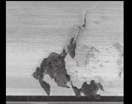
Точечный поверхностный дефект (выкрашивание)
